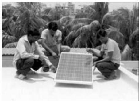
Trabalhadores instalam um painel solar sobre o telhado da casa.
